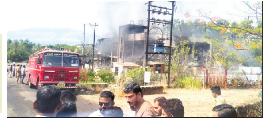
तासवडे एमआयडीसीतील S.K.S. फाईन केम कंपनीत स्फोट झाल्याने आग लागली. या आगीत कंपनी जळून खाक झाल्याचे दिसत आहे.
